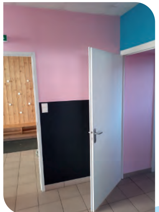
Travaux de peinture à la salle Coquelicot.
