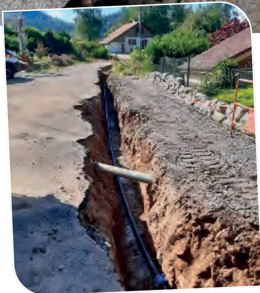
Renouvellement du réseau d'eau Rue de la Chaume.
