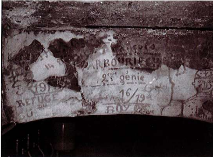
Graffitis visibles dans les sous-sols de la mairie.
