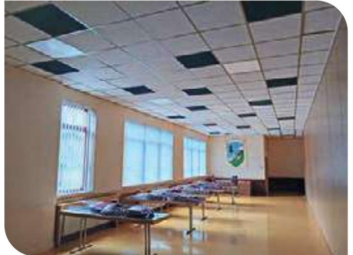
Plafond de la salle de bar de la Familiale.
