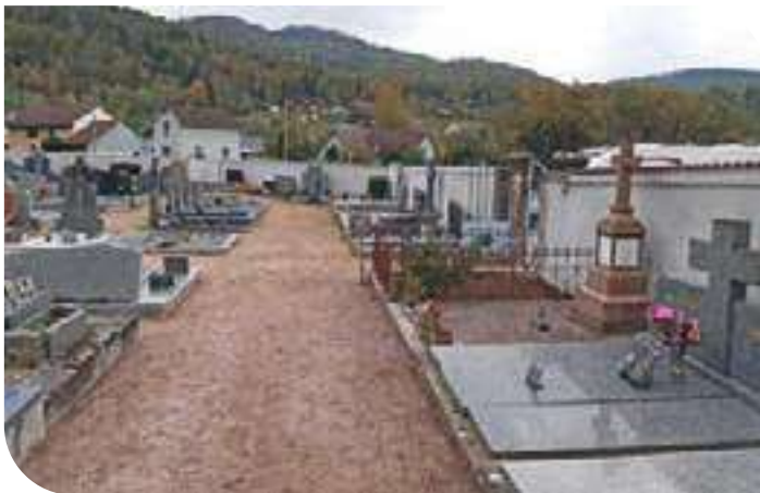
Travaux finis au cimetière.
