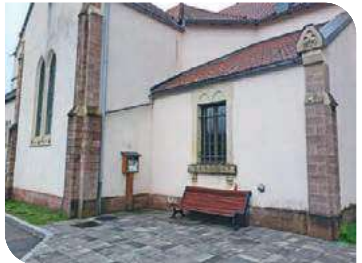
Installation d'un défibrillateur.
