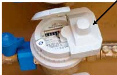
Le service d'eau a pour but de simplifier la vie de ses abonnés parfois absents lors des relevés de compteurs et de ses techniciens. Pour cela des nouveaux compteurs peuvent être installés, ou modifiés afin d'y ajouter un appareil permettant de récupérer à distance votre consommation : la radio relève.
